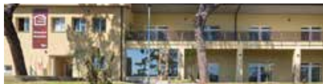
la sede distaccata ubicata nell'immobile posto a Terranuova Bracciolini , adiacente alla nuova Casa della Salute – via Donizetti n.2;
