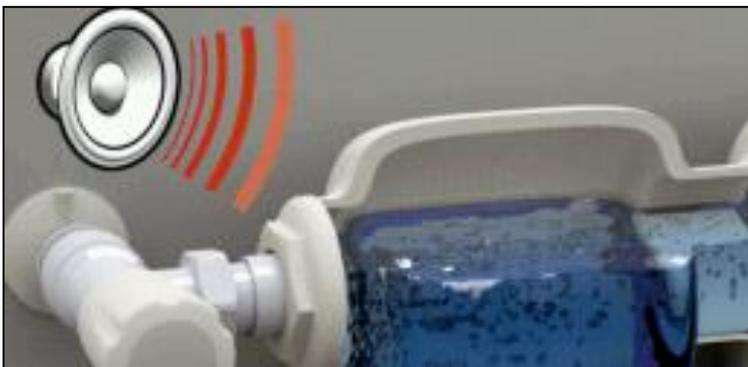
**Rumorosità dei corpi scaldanti** per il passaggio di bolle e microbolle attraverso le valvole dei radiatori
