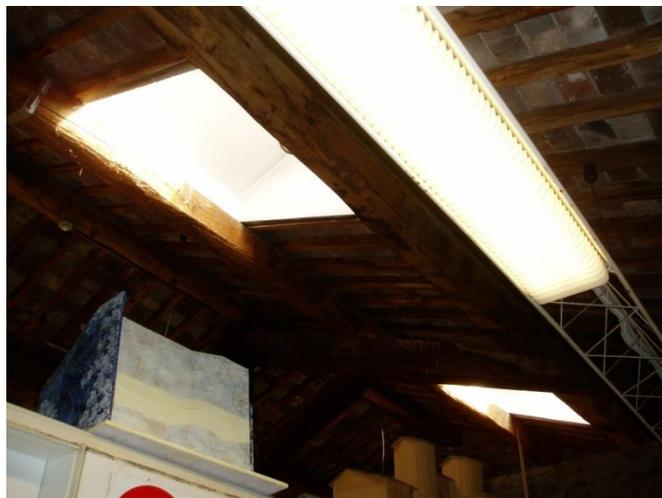
Foto 2: Vista interna – Particolare copertura in legno
