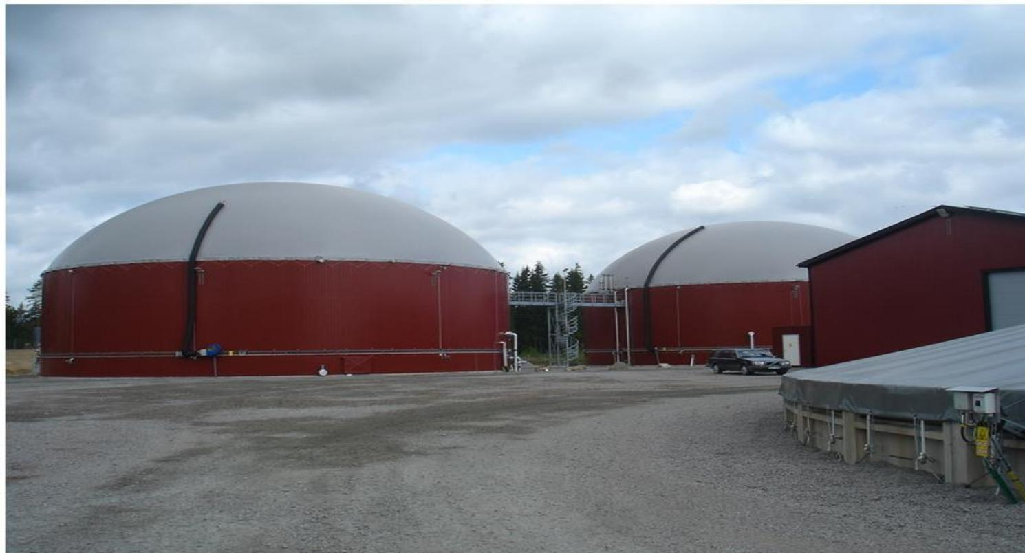
**Impianto con produzione di 500 mc/h di Biogas → 250 Smc di Biometano**
