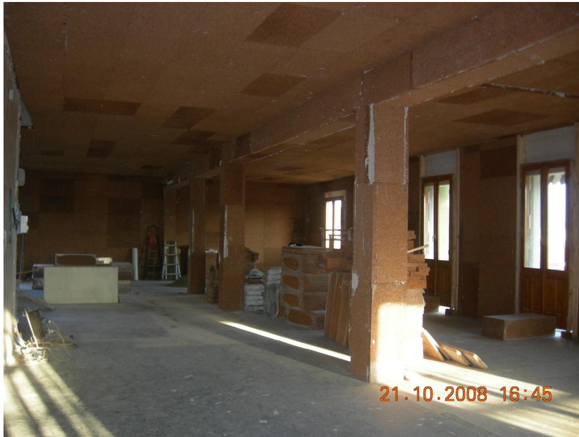
Riqualificazione energetica di un appartamento in un condominio
