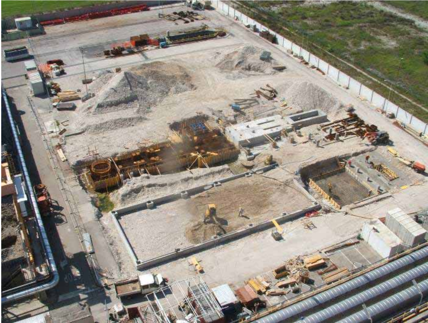
Lavori presso il sito
