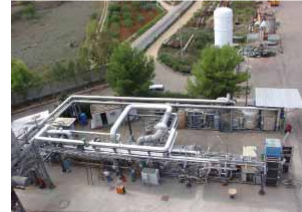
Impianto ITEA di Gioia del Colle
