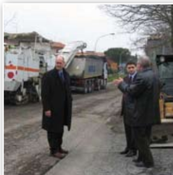
Alcune fasi dei lavori sulle strade provinciali
